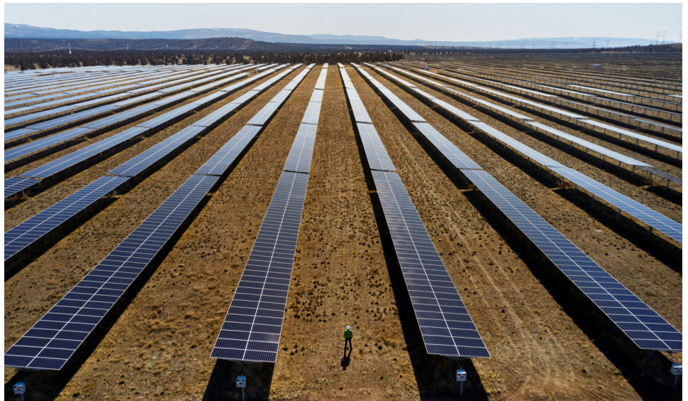
Solar Farm von Apple liefert erneuerbare Energie.
