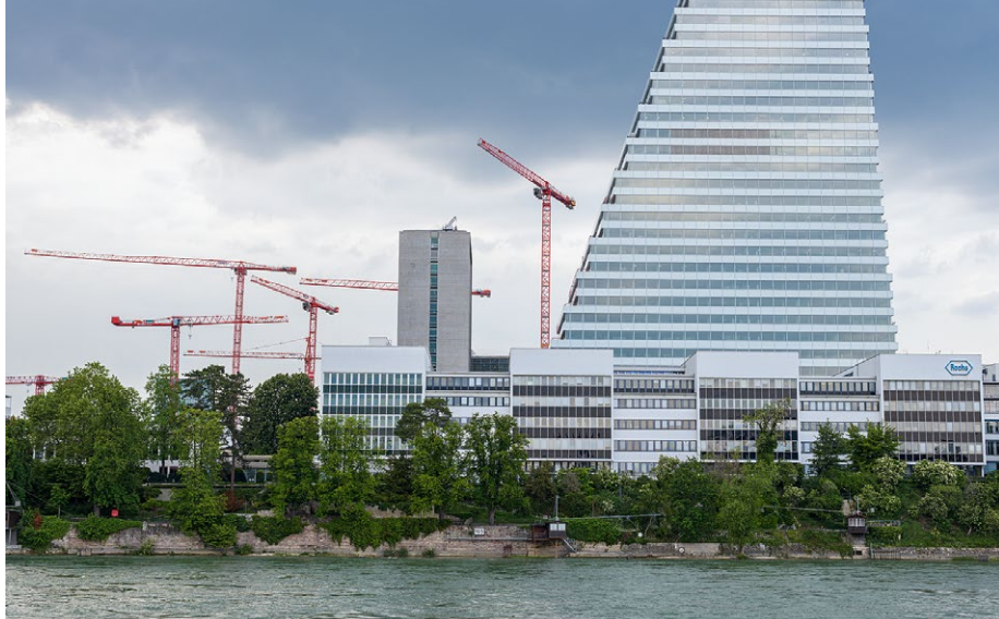
Am Rheinufer gegenüber der Papiermühle liegt die Baustelle des Roche Campus. Der im Bau befindliche zweite Turm (hinter dem bestehenden mit 178 m Höhe) wird mit 50 Etagen bzw. 205 m das höchste Bürogebäude der Schweiz werden und soll 2022 fertiggestellt sein.
