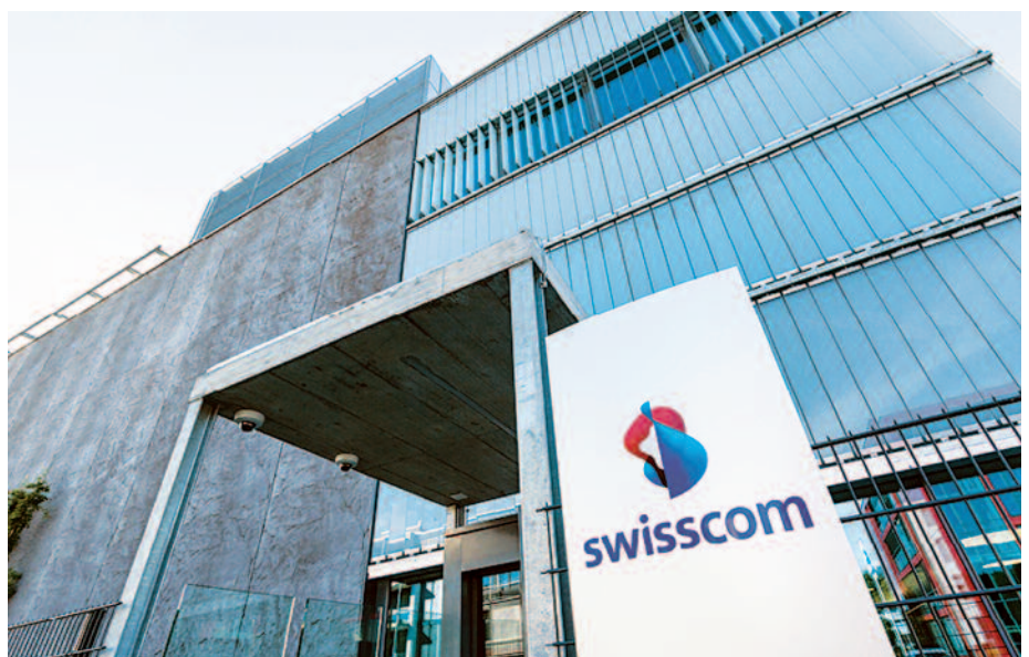
Hightech im Rechenzentrum der Swisscom in Bern-Wankdorf. Foto: Swisscom
